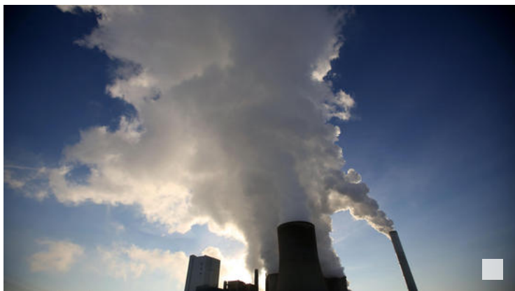
Braunkohlekraftwerke in Nordrhein-Westfalen.
