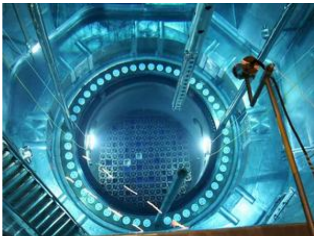
Brennelemente im Blick. Im Atomkraftwerk Philippsburg 2 werden die Brennelemente gewechselt. Das Bild zeigt das Innere des Reaktorkerns. Neue Atomkraftwerke rechnen sich nicht mehr... - FOTO: DPA
