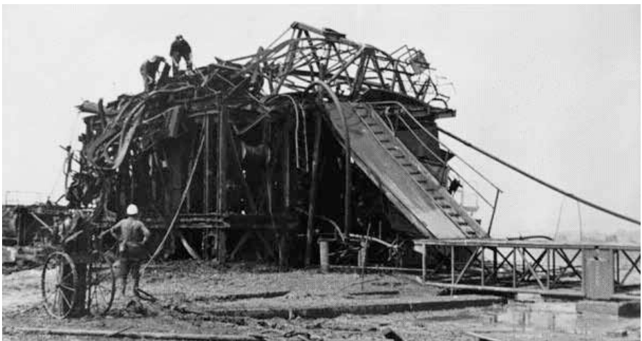
Der eingestürzte Bohrturm 1969, Foto aus Akte des BStU
