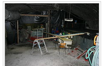
Lagerbecken (mit Folie abgedeckt, rechts) und Abtransport der Salzlauge auf der 658 m-Sohle
