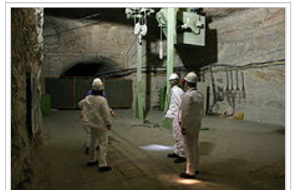
Zufuhrkammer über der Kammer 8a. Durch den Schieber im Boden wurden die Fässer mit mittelaktivem Abfall in die Kammer 8a abgelassen
