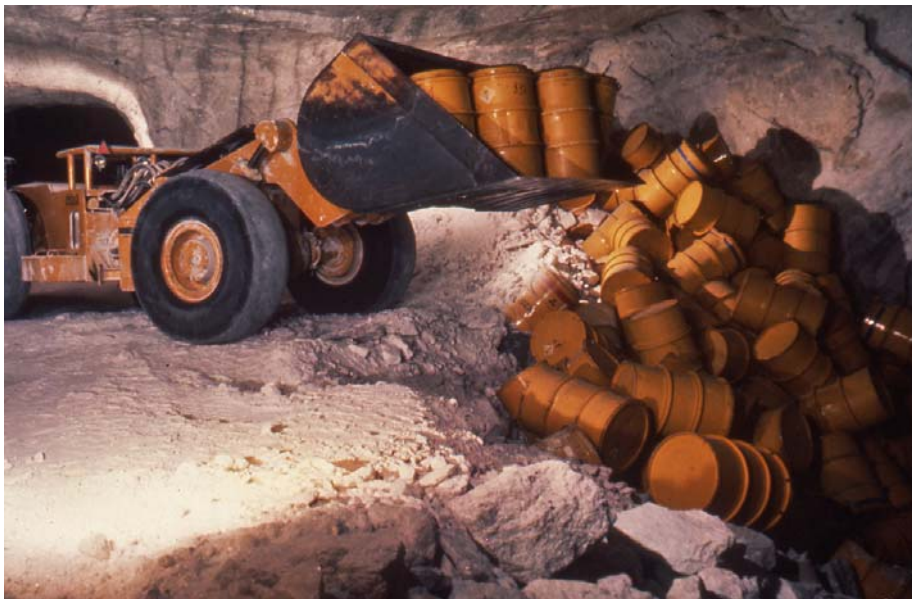
Abkipptechnik in Kammer 7 (725 m - Sohle)
